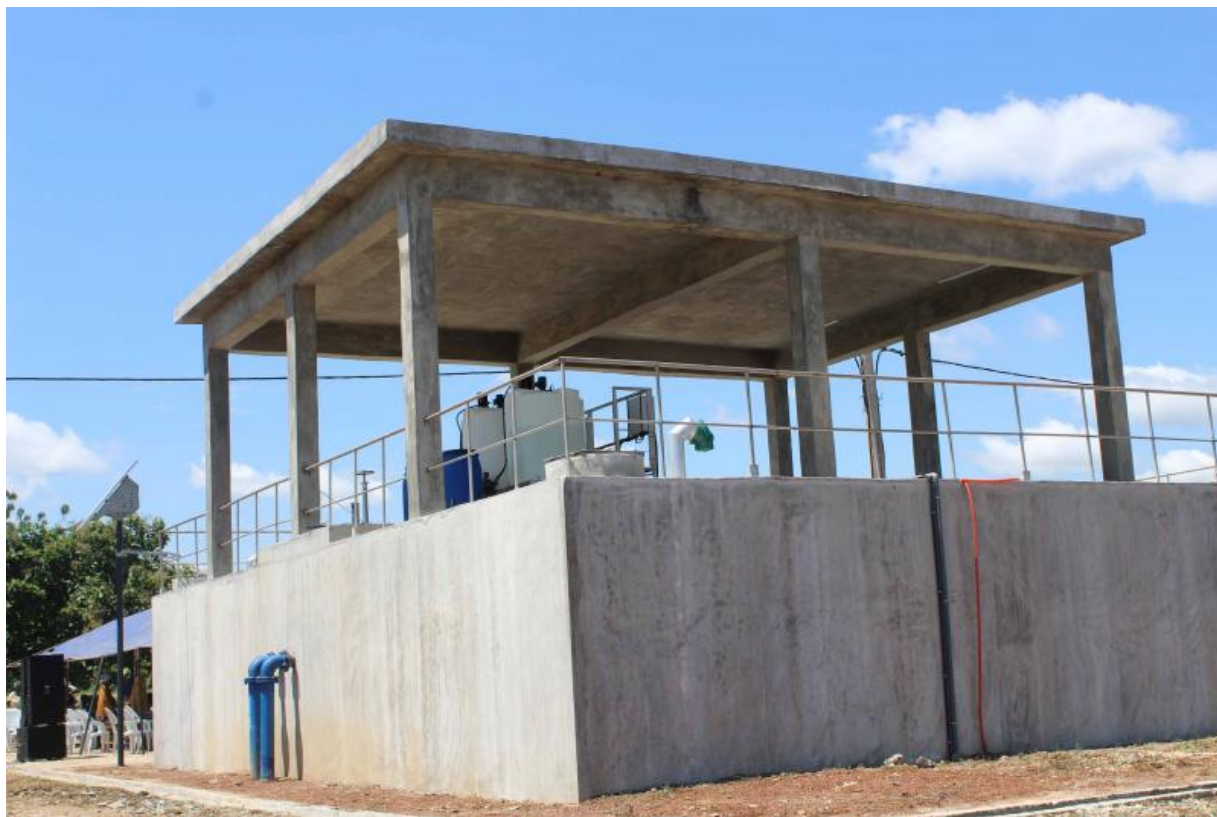
Infrastructures de captage, de traitement, de stockage et de distribution d'eau réalisées dans les communes de Dassa et de Glazoué
